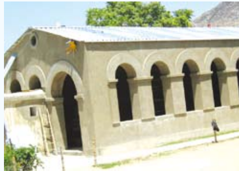
▲屋根と壁が完成した体育館
