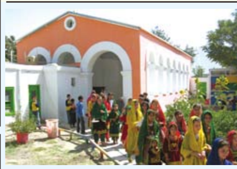
▲外壁塗装が完了した体育館
